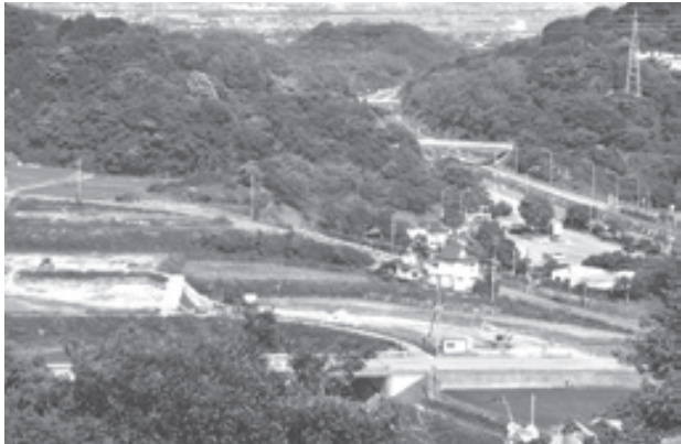
▲工事が進むスマートインターチェンジ
