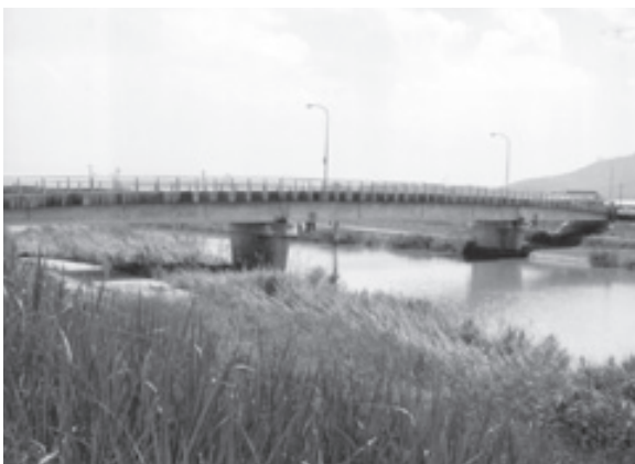
▲市に移管される砥川大橋（橋長116m）
