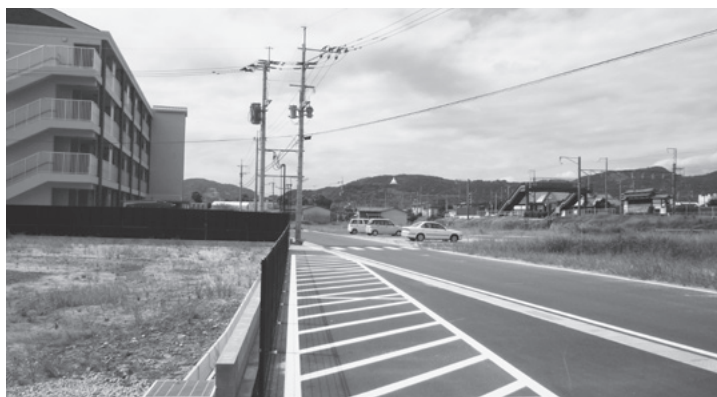
▲牛津駅南の現状と建設中の小城市営住宅
