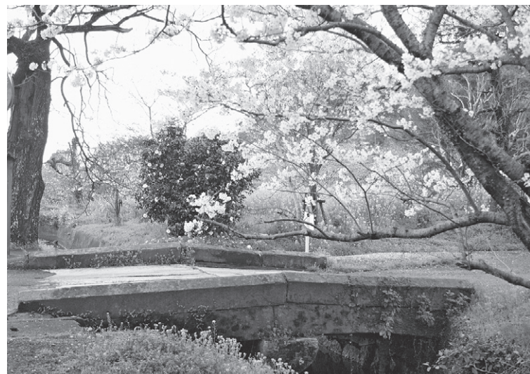
▲修景整備が予定されている小城藩邸石橋
