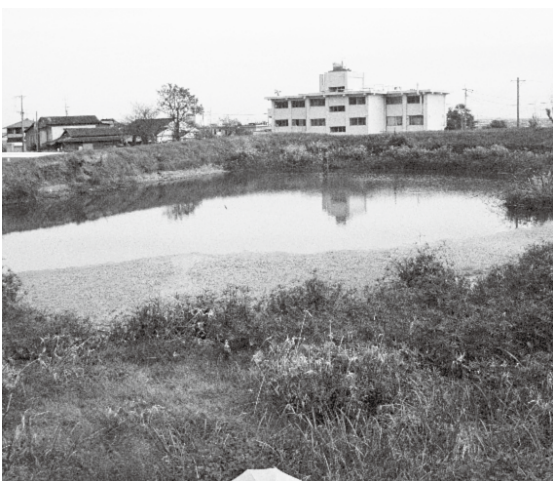
▶ため池耐震性調査予定の寺浦第3ため池
