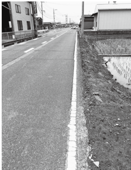
▲県道牛津芦刈線の歩道がない区間
