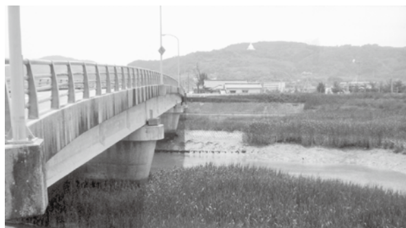
▲橋桁が堤防より低いため流水を遮るおそれがある砥川大橋
