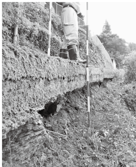
▲江里山小林線の路肩崩落現場
