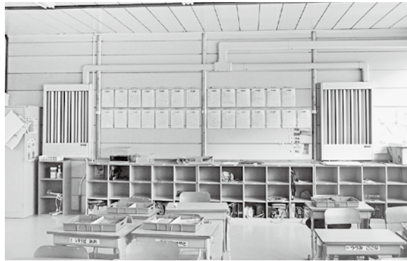
▲幅射パネル実験設置～牛津小仮設校舎
