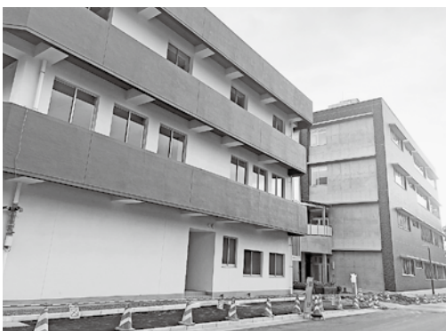
▲建設が進む西九州大学看護学部のキャンパス
