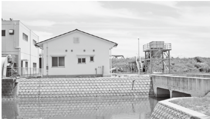
▲31年稼働予定で増設工事が進む牛津町前満江の排水ポンプ
