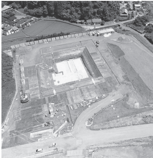
▲建設が進むごみ焼却場 「クリーンヒル天山」(多久市)
