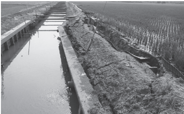
▲7月豪雨による法面崩壊
