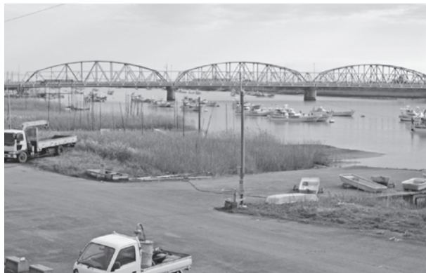
▲浚渫が待たれる小城市住ノ江漁港
