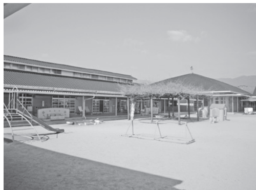
▲保育室への空調設置が待たれる公立幼稚園
