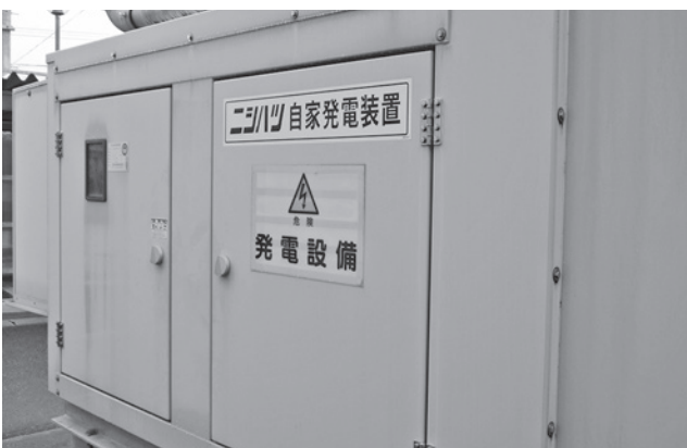
▲市役所庁舎の自家発電装置
