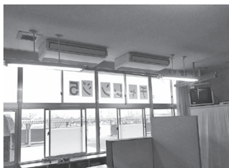
▲すべての普通教室に設置されるエアコン
