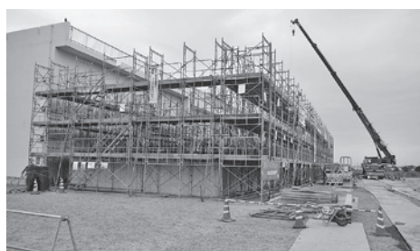
▲三日月浄化センター3・4号棟(平成25年)の工事
