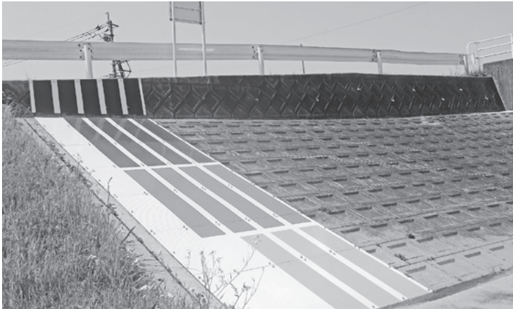
▲砥川大橋護岸に設置されたレベル表示(上)と危険水位表示板(下)
