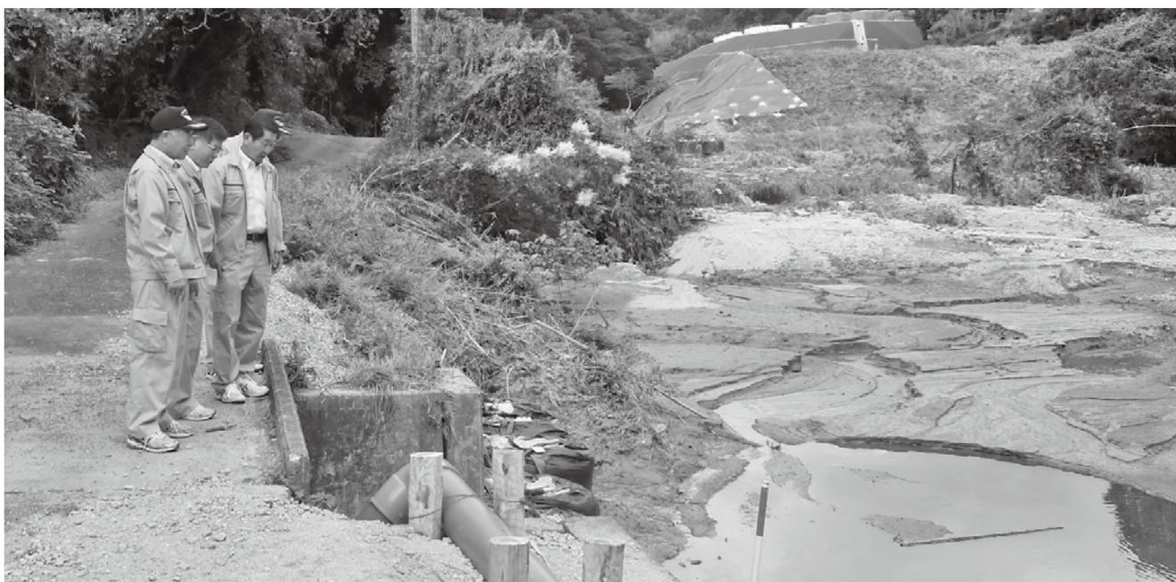
▲西分第1ため池の堤防決壊により、土砂が流入した第2ため池（三日月町西分）
