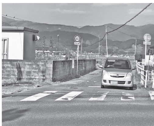
▲一日も早い道路拡幅が待たれる西の橋交差点
