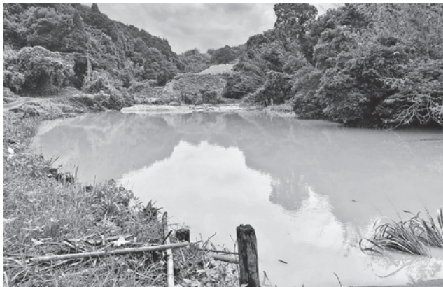
▲越水した西分第2ため池
