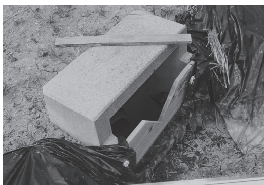
▲田んぼダムに設置されたV字カットの堰板
