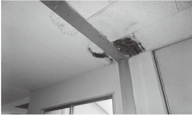
▲老朽化し雨漏りでカビが生えた天井 (写真は桜岡小)
