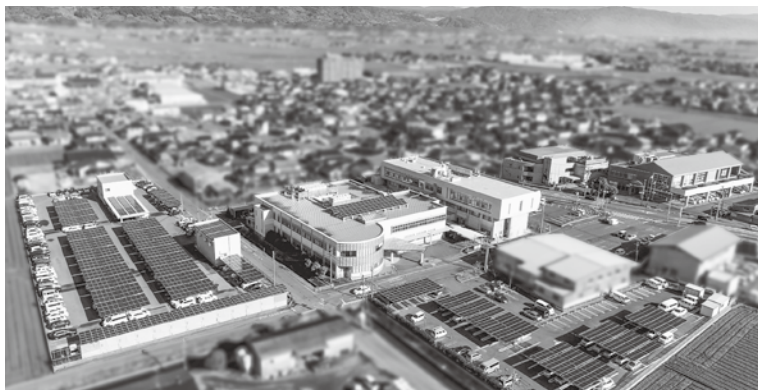
▲小城市役所に設置された太陽光発電パネル
