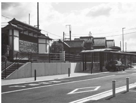
▲駅利用者の駐車場がなくなった牛津駅
