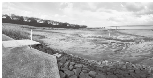
▲海遊ふれあいパーク干潟体験場の浚渫工事
