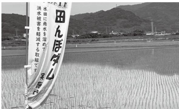
▲下流域の浸水被害を軽減させる田んぼダム
