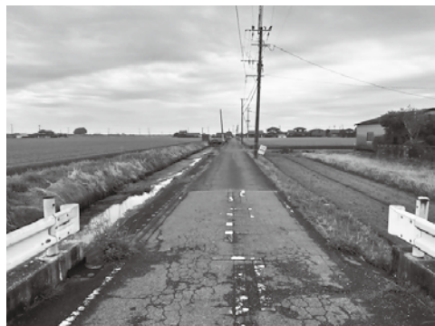
▲道路幅員が狭い四条三ヶ島2号線
