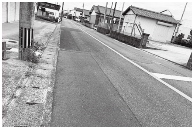
▲歩道も外側線もない通学路
