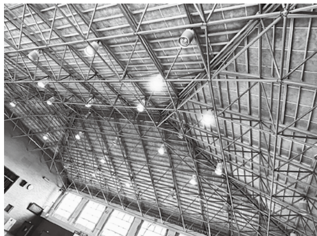
▲照明器具の更新が予定されている三日月小学校体育館
