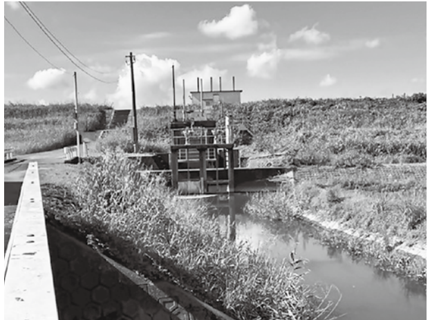
▲大雨時に迅速な排水対応が必要な重要な水門
