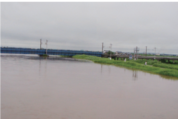
(上) ドゥイング三日月前 水路が増水し、道路が冠水。 (下) 牛津川 牛津地区の一部に避難勧告がだされた時の水位。 JRの鉄橋下数メートルまで水かさが増している。
