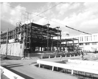
▲増築庁舎鉄骨柱の組立状況。
