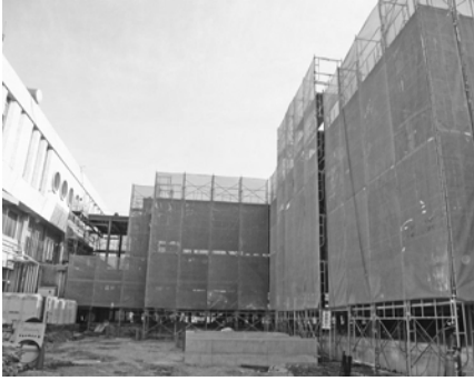
三日月庁舎(左側)と増築庁舎(右側)
