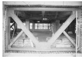
④鉄骨ブレース・RC壁補強
