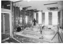
⑥内部（2階）の解体工事
