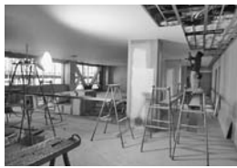
⑦内装工事の写真
