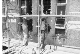
①外壁コンクリートの撤去
