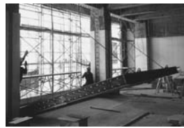
③鉄骨ブレースの取り付け
