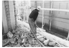
②施工アンカー・腰壁の撤去
