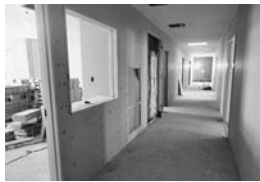
⑧内装工事の写真
