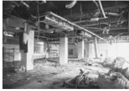
⑤内部（1階）の解体工事
