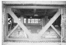
④鉄骨ブレース・RC壁補強
