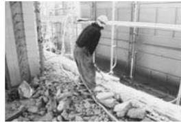
②施工アンカー・腰壁の撤去
