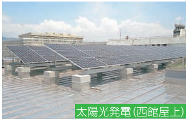
太陽光発電(西館屋上)
