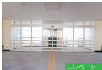
エレベーター
