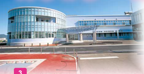
完成した 小城市役所新庁舎
