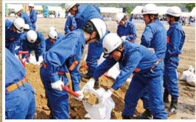
消防団による水防工法
