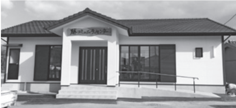
▲勝コミュニティセンター 外観
