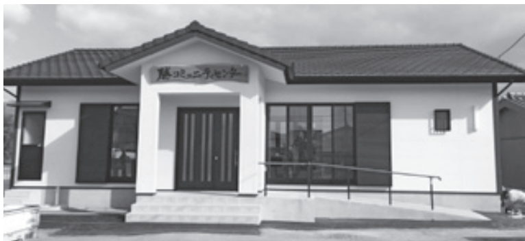
▲勝コミュニティセンター 外観
