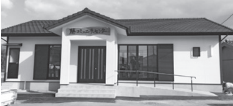
▲勝コミュニティセンター 外観
