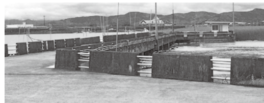
臨港道路(荷揚棧橋)
