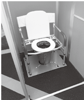
▲マンホールトイレ
