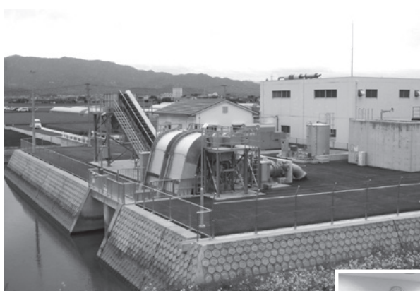
▲「前満江第2排水機場」外観
