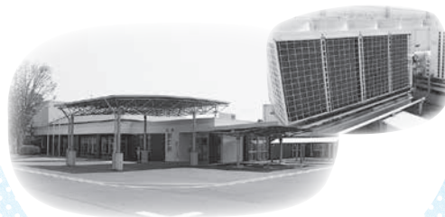
▲牛津公民館と空調設備
