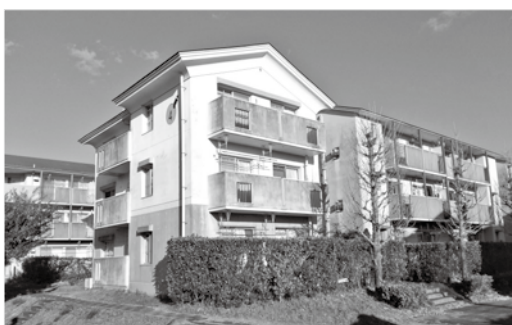
◀県営小城団地(小城町)
