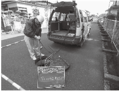
▲管路点検状況
