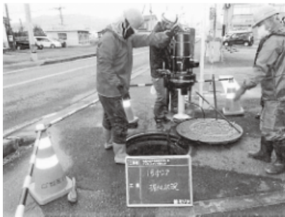
▲下水道施設修繕状況
