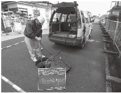
▲管路点検状況
