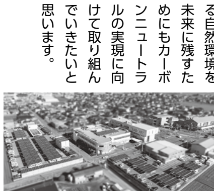
▲市庁舎駐車場の太陽光パネル
