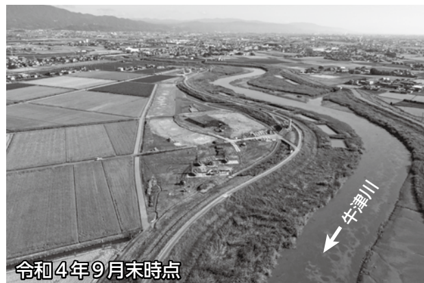
堤防整備状況
