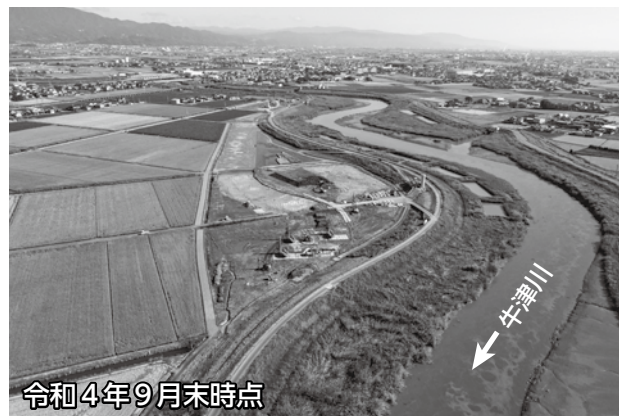
堤防整備状況
