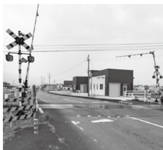
▲第一種踏切（五の坪踏切）
