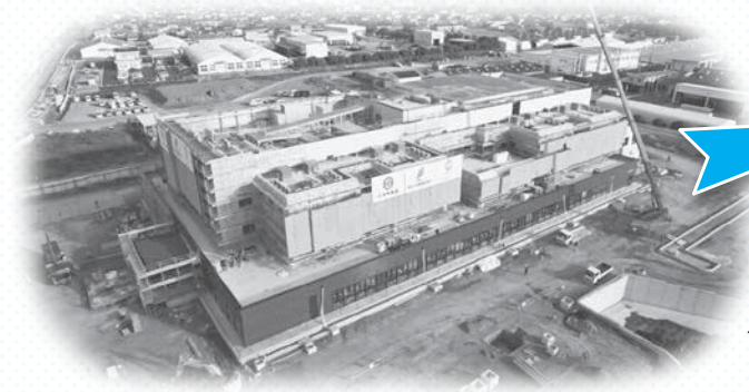
◀新病院建設現場の様子 (多久市東多久町別府)
