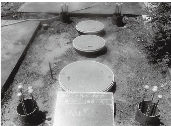
▲埋め戻し完了の合併浄化槽
