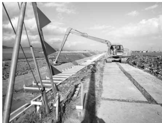
▲改良工事が進む市内のクリーク
