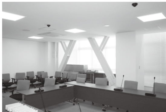
▲東側庁舎の対震対策
