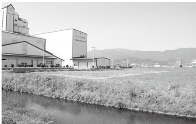
▲小城市処理区の中継ポンプ場建設の三日月町仁俣地区
