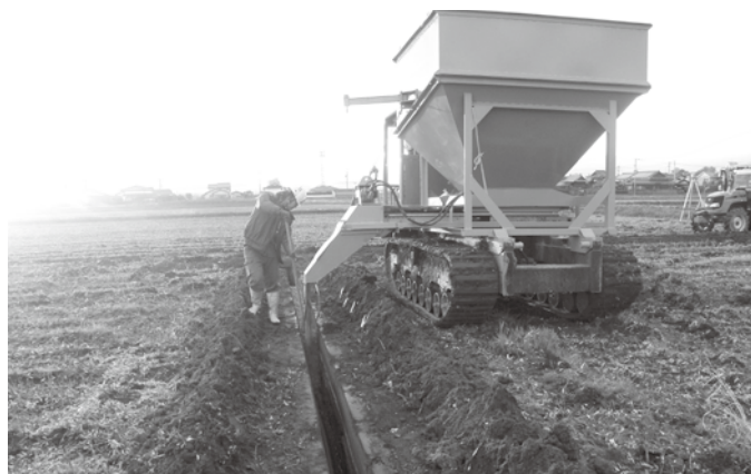
▲トレンチャーによる暗渠排水事業
