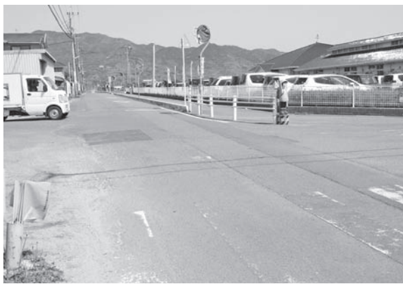
▲三日月幼稚園南西角の交差点、改良が急がれる
