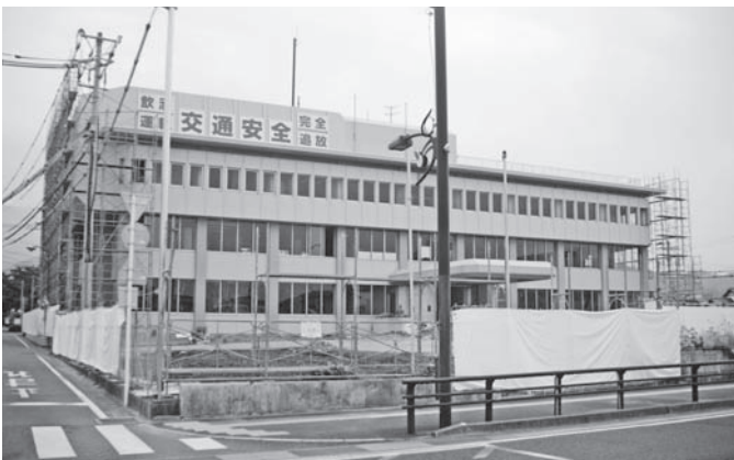
▲市民交流プラザ(仮称) 建設のため解体が進む旧小城市庁舎
