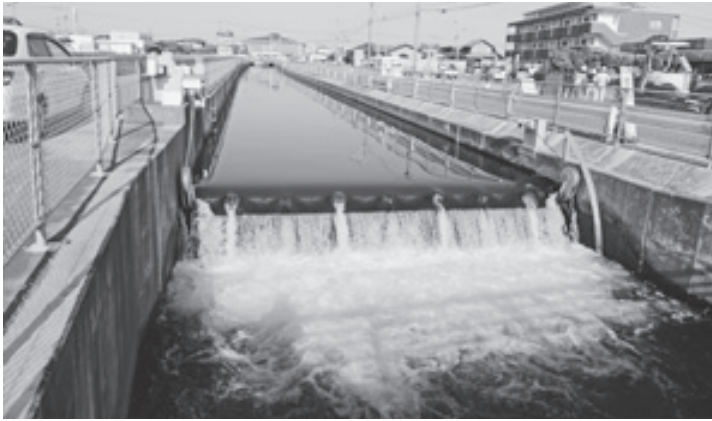
▲全開された大寺転倒ゲート
