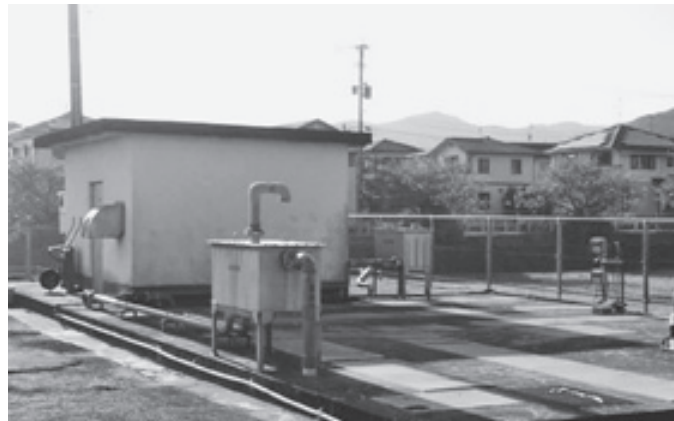
▲現在の東新町の処理施設
