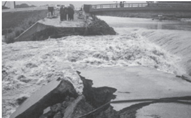
▲小城町門前地区 晴気川堤防決壊 (平成2年7月)
